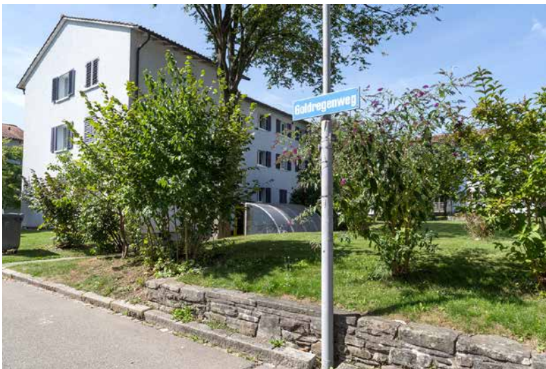
Innenhof von Jasminweg 1 und 2 (oben und Mitte). Siedlung Goldregenweg (unten).
