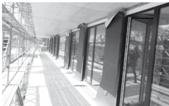
Bilder vom Neubau Waid
