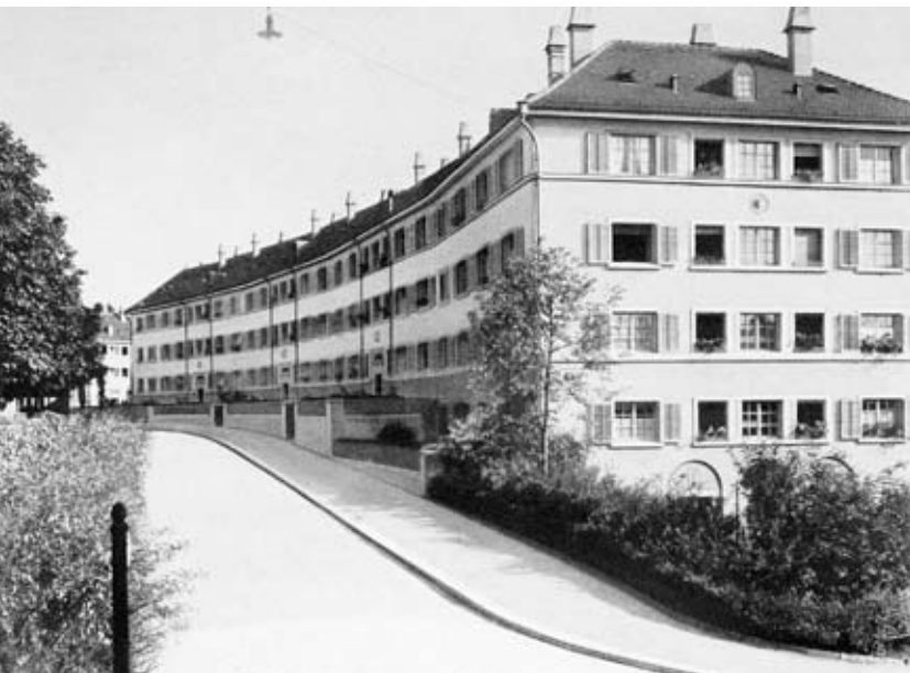
Kolonie Imfeldsteig–Imfeldstraße (Straßenansicht)
