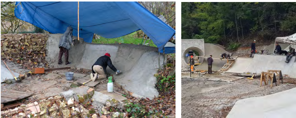
Construction d'un skatepark privé à gauche et aide pour le park de Saint-Jean-De-Maurienne
