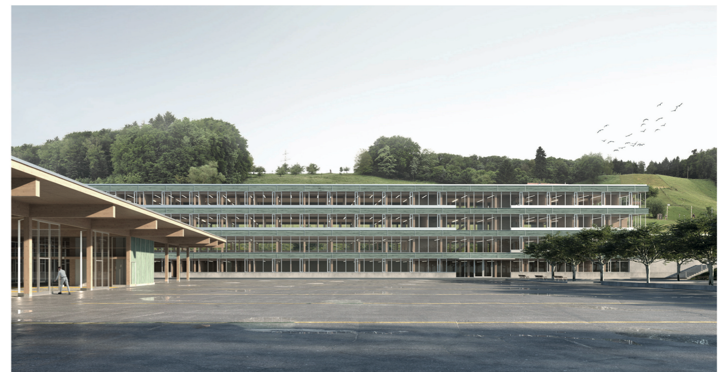
Der zeilenartige Büroholzbau bildet das Rückgrat des ebenen Verkehrsplatzes mit Prüfhalle.
