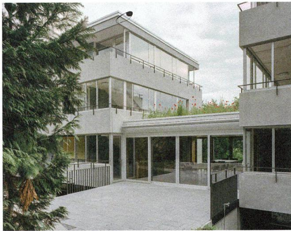
Seit die Hauseingänge im Untergeschoss liegen, dient der Zwischenbau als Gemeinschaftsraum.
