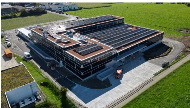
Der Neubau hat rundherum Solarpanels. Das Bild entstand im September 2025.
