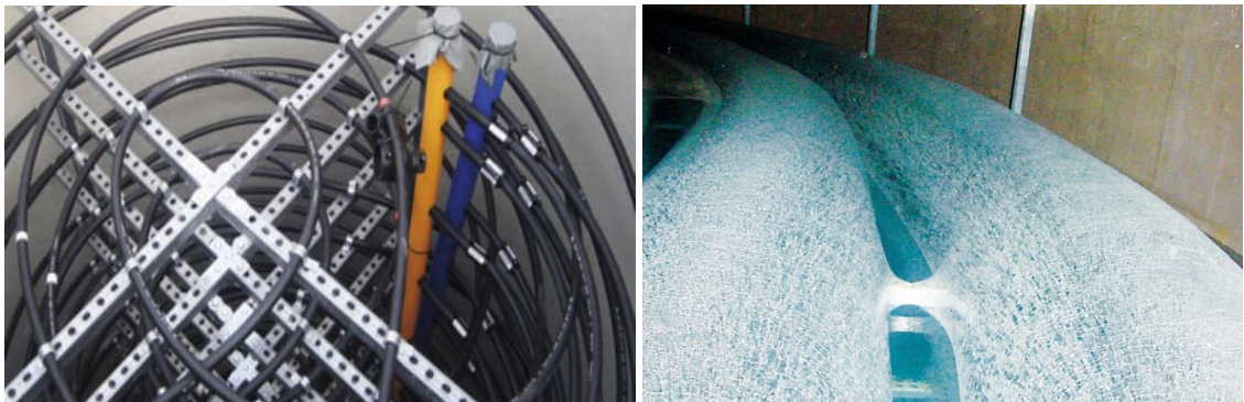
Fig. 9-6 Innenansicht Eisspeicher (Quelle: Viessmann) rechts vereister Speicher
