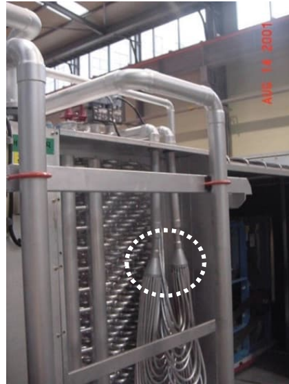
Fig. 4-7 Verteilung am Verdampfer
