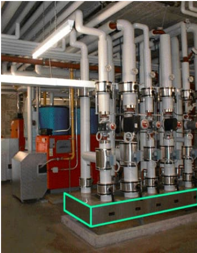
Verteiler als Bindeglied zwischen Erzeuger- und Verbraucherseite
