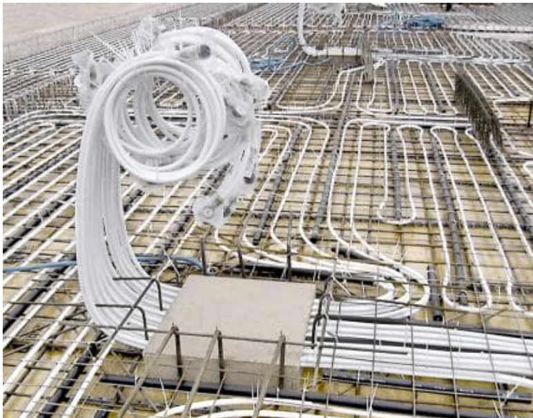
Fig. 3-15 Eingelegte Rohrleitungen zur Temperierung der unverkleideten Geschosssdecke (Quelle tabs)
