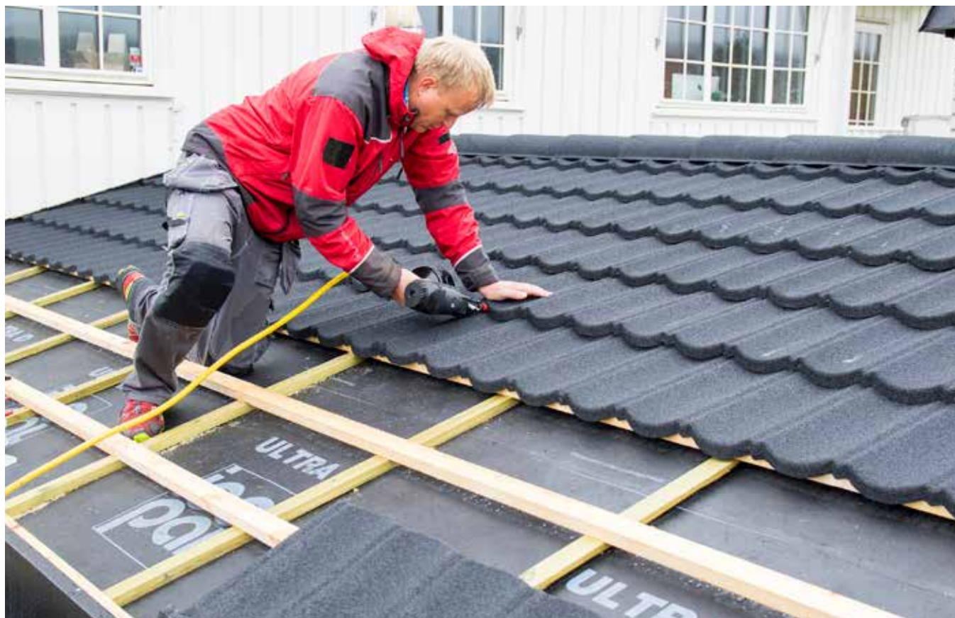
Montering av AeroDek Tradition Plus på bærende undertak, tekket med Icopal Ultra D underlagsbelegg
