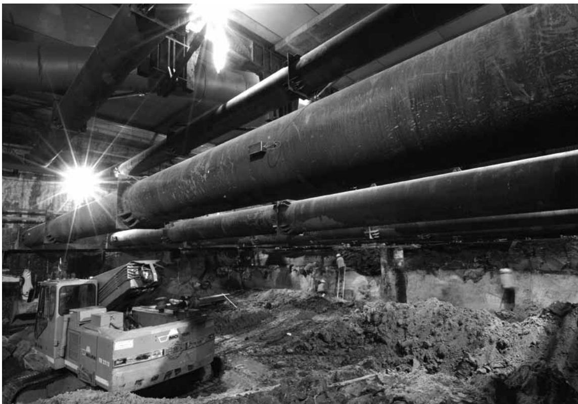
2 NZR2 (08-08-25) 0015 Tijdens het ontgraven van de bouwput van ongeveer 11 tot 15 meter –NAP wordt een deel van een profiel door de top van de eerste zandlaag (top van het Pleistocene zand) schoongemaakt
