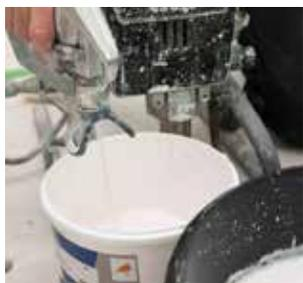
**7** Videz ainsi la peinture du tuyau jusqu'à ce que de l'eau sorte du pistolet. Réduisez la pression jusqu'à ce que la machine s'arrête. Relâchez la gâchette du pistolet. Toute la peinture est à présent sortie du tuyau et du pistolet.
