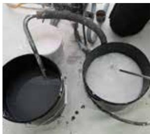
**10** Prenez maintenant de l'eau claire et rincez le tuyau et le pistolet jusqu'à ce que de l'eau (presque) propre en sorte. Rincez ensuite le tuyau de retour en le plaçant au-dessus du seau jusqu'à ce que de l'eau presque propre en sorte.
