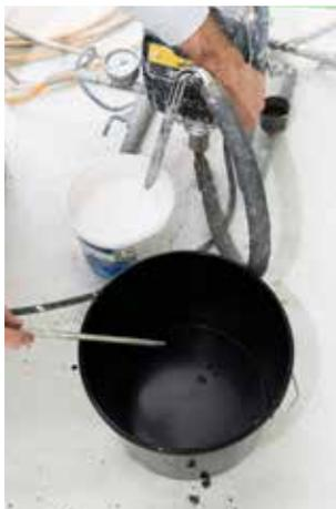
**1** Placez le tuyau d'aspiration dans le seau de peinture et le tuyau de retour dans un seau vide. Purgez l'installation en plaçant le bouton de fonction sur « Circulation ».
