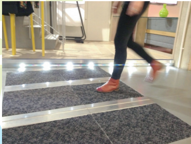
figuur 3: Energieopwekkende tegel PaveGen
