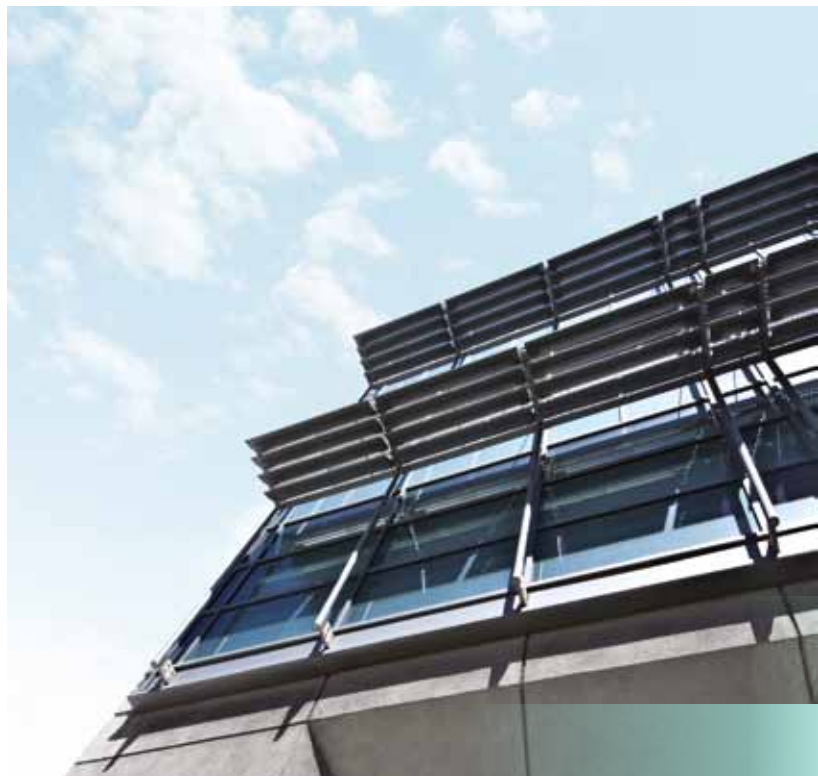
Zonnepanelen op kantoorgebouw
