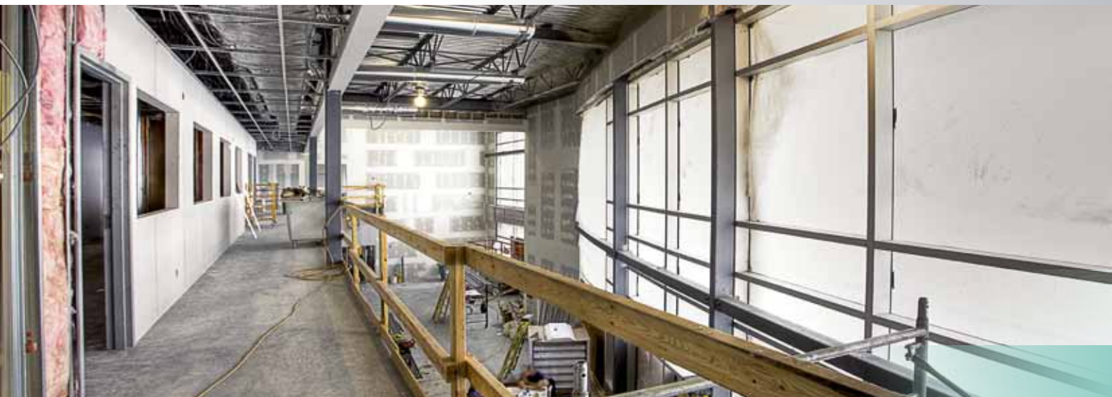
Renovatie bestaand gebouw
