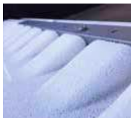
Detalle de instalación de rastrel
