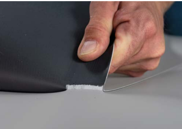
Figura 12. Realización de una prueba de soldadura.
