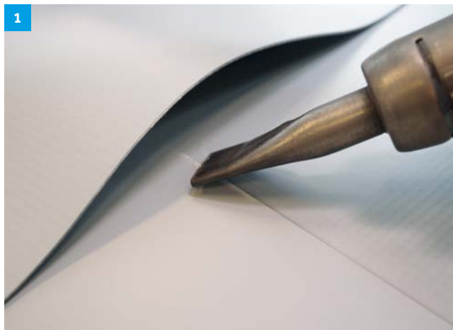
Figura 15. Comprobación de la unión con una sonda.
