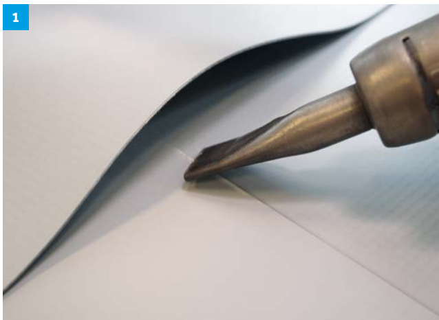
Figura 15. Comprobación de la unión con una sonda.
