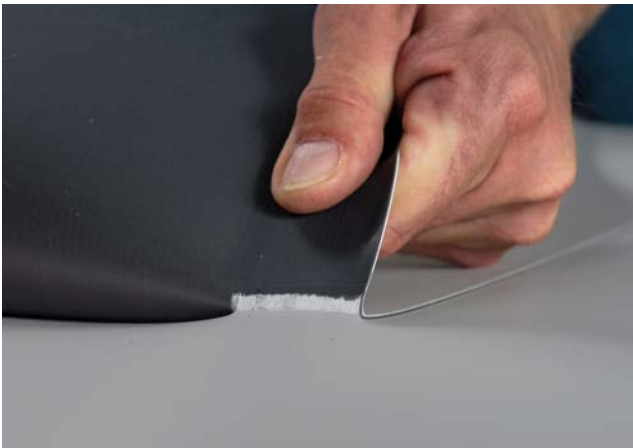
Figura 12. Realización de una prueba de soldadura.
