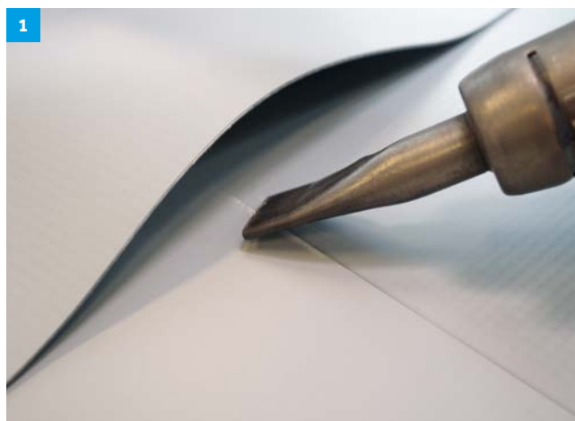
Figura 15. Comprobación de la unión con una sonda.
