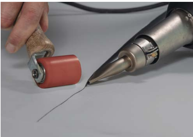
Figura 13. Soldadura manual con soldadora y rodillo de silicona.
