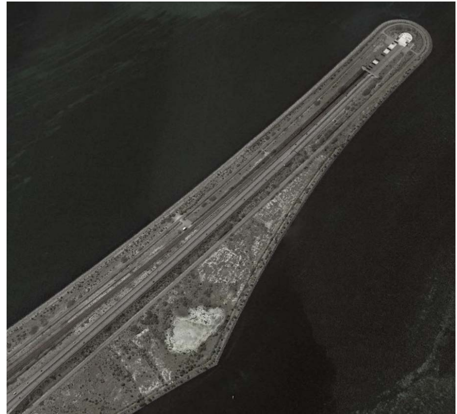
Figur 8 Översiktsvy över Öresundtunneln. Källa: Google earth 2021
