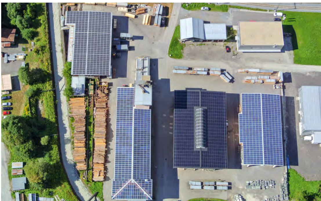
Abb. 3: Großflächige PV-Anlage auf einem Industriebetrieb.
