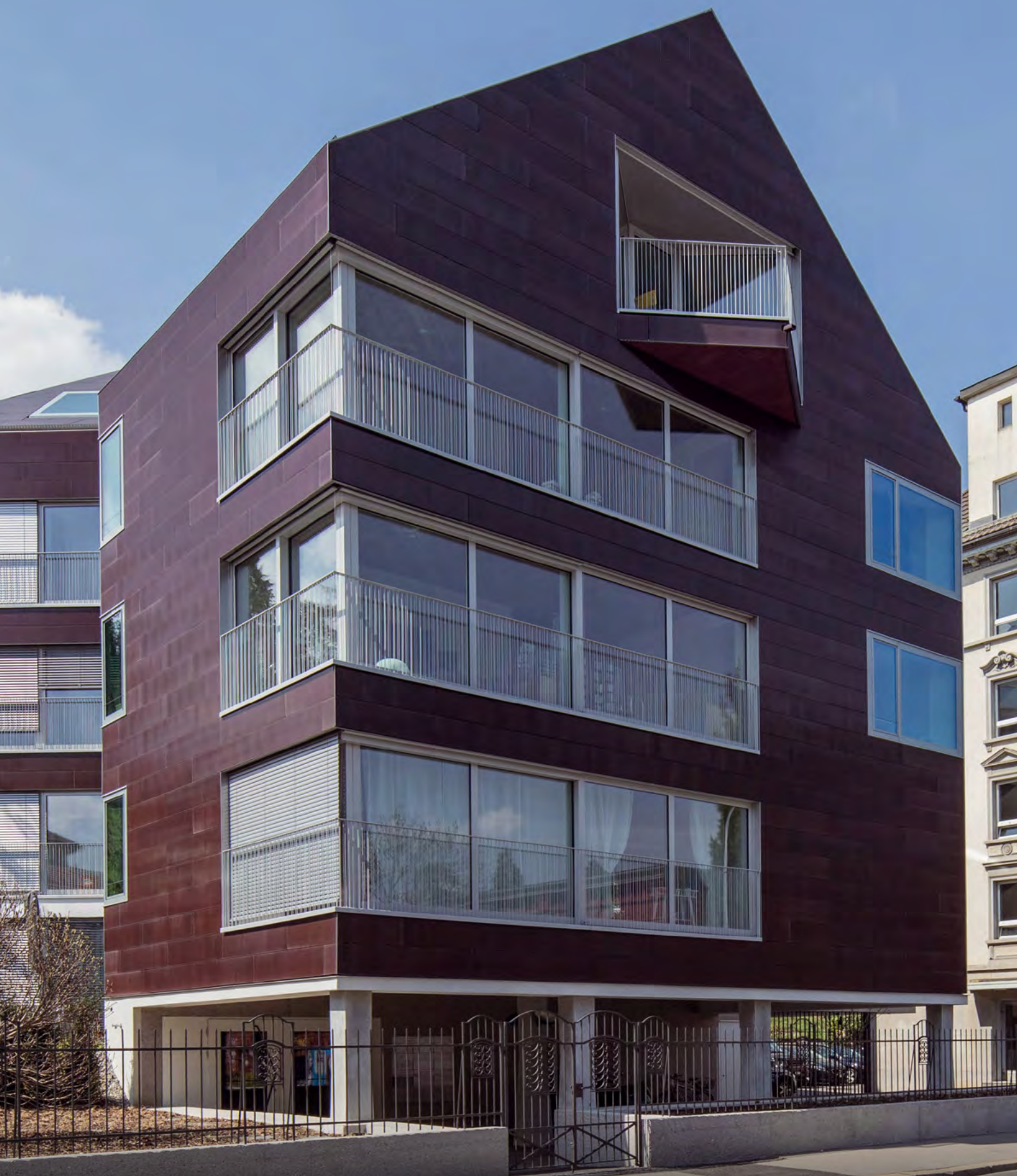
Abb. 35: Maßgeschneiderte Photovoltaik-Fassadenelemente farblich angepasst an die Architektur ermöglichen – hier backsteinrot – gestalterische Highlights. BIPV-Fassaden tragen zum Plusenergiestandard bei. Quelle: Ertex Solar
