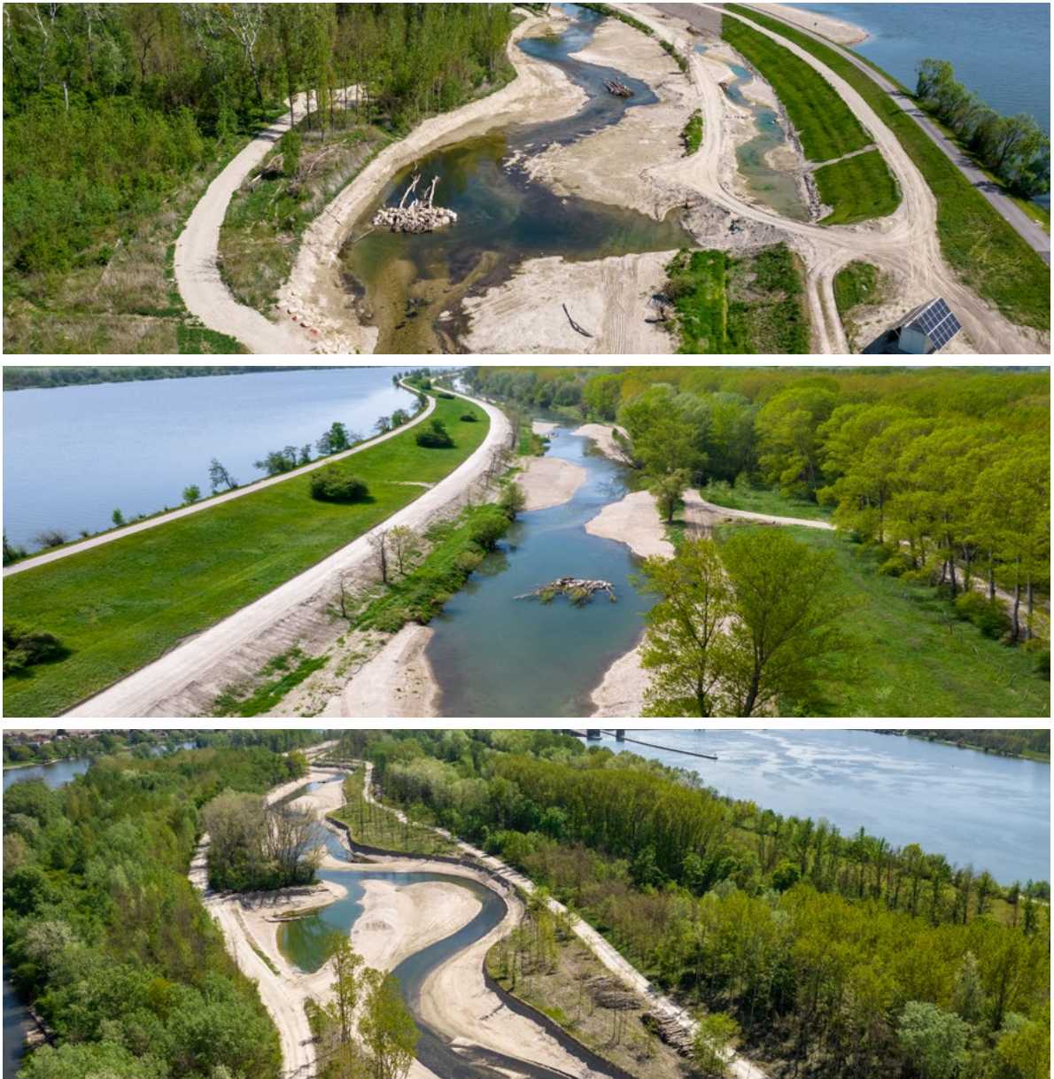
Abb. 2: Abschnitte des Umgehungsarms: oben – Rampengerinne, Mitte – renaturiertes Krems-Kamp-Gerinne, unten – neu errichteter naturnaher Mündungsbereich, Mai 2021. Fotos: J. Wiedl/VERBUND.
