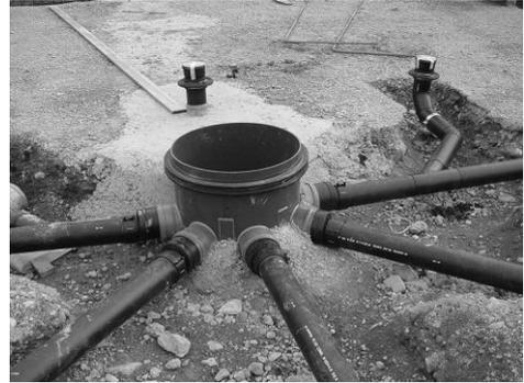
Schächte werden üblicherweise an allen Richtungs-, Neigungs- und Querschnittsänderungen verbaut. Sie bilden damit einen wesentlichen Teil des Kanalisationssystems und müssen dementsprechend die gleiche Funktionalität wie das übrige Kanalrohrsystem aufweisen. **Insbesondere müssen Schächte bis zur Oberkante dicht sein.**
