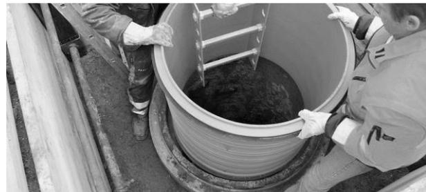
Kunststoff-Systemlösungen bieten mit Schacht-in-Schacht-Sanierungen hingegen eine wirtschaftliche und dauerhafte Lösung dieses Problems.
