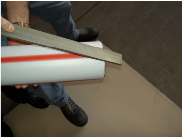
Bild 10: Anschrägen mit Raspel
