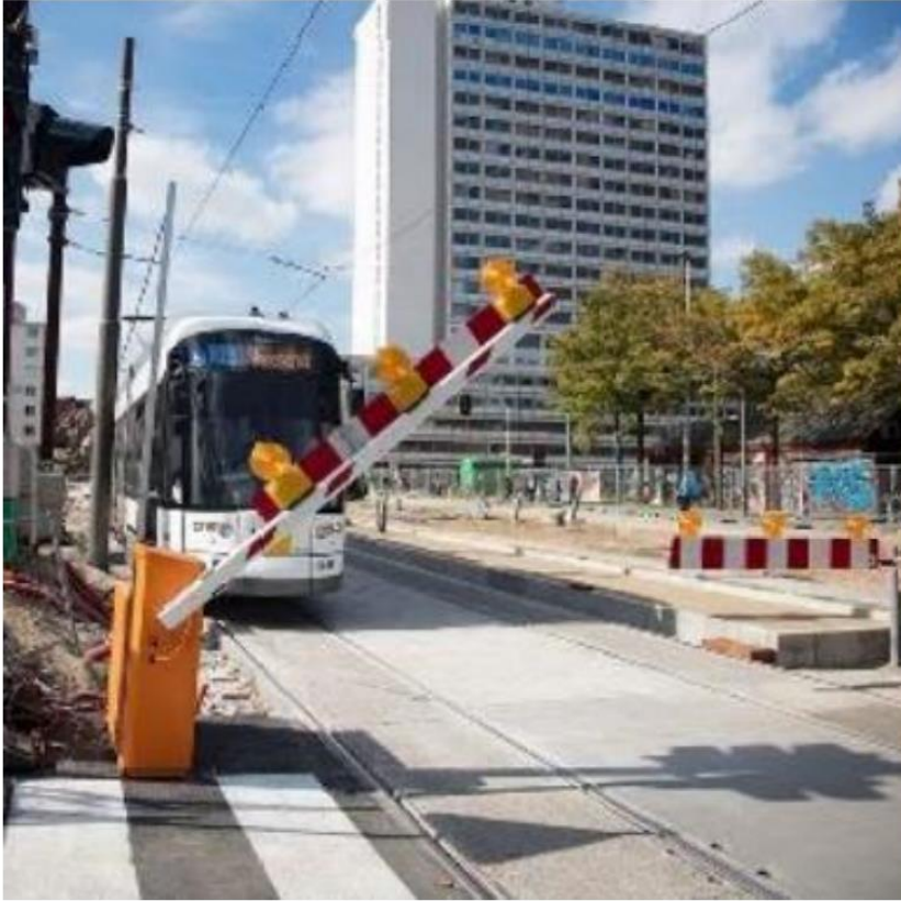
Figuur trambareel met detectie hoogtesensor
