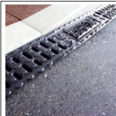
Lijnafwatering met roosters
