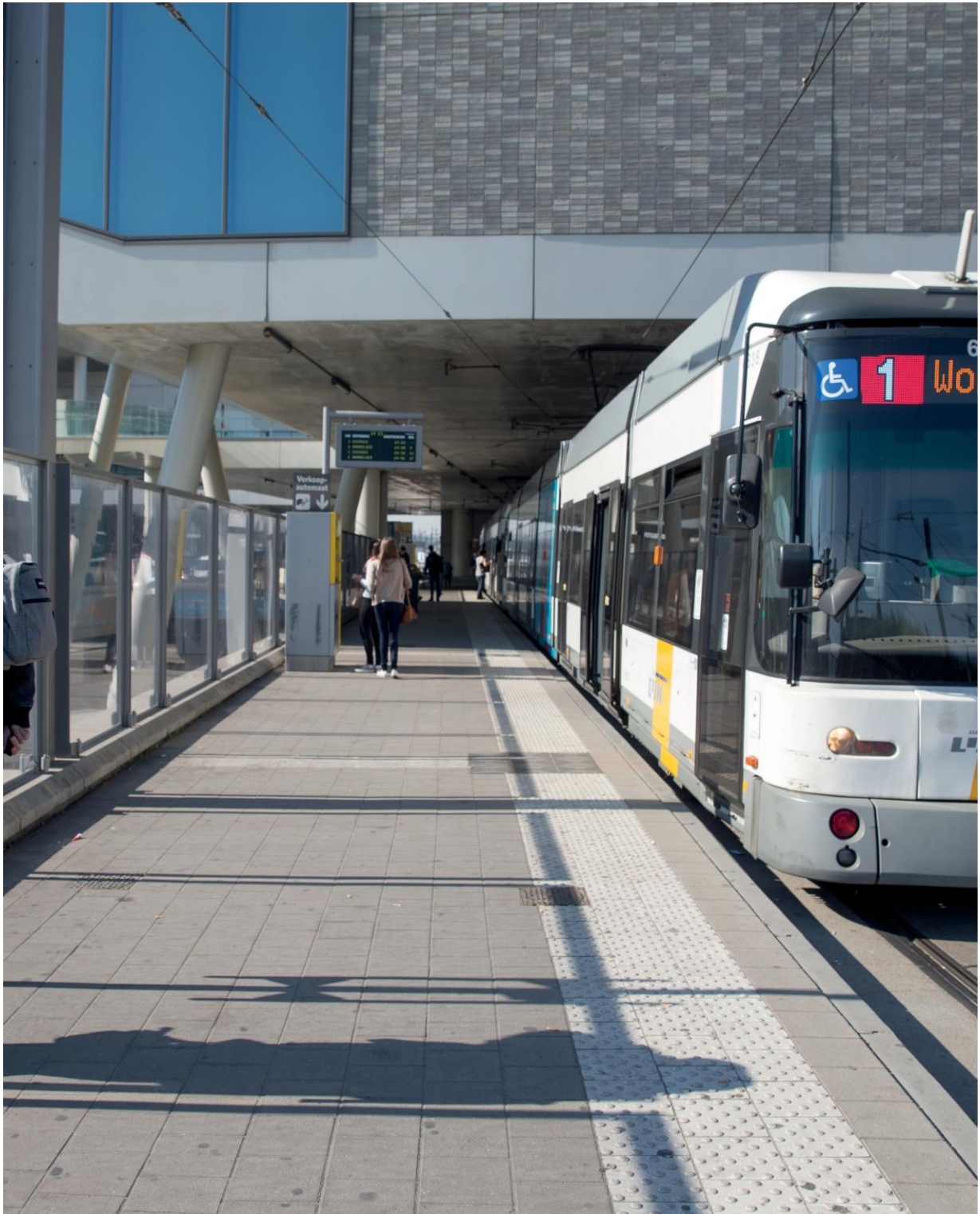
Tramhalte met veiligheidsstrook in noppentegels over de volledige lengte van het perron.
