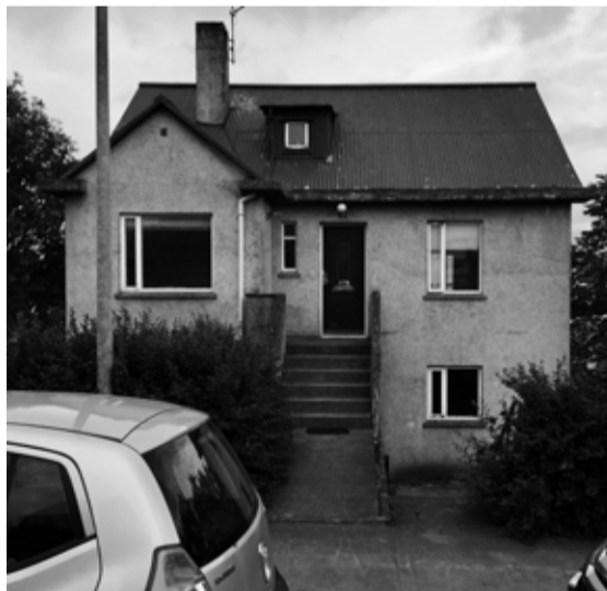
Þarna ólst Óskar upp. Hjallavegur 29
