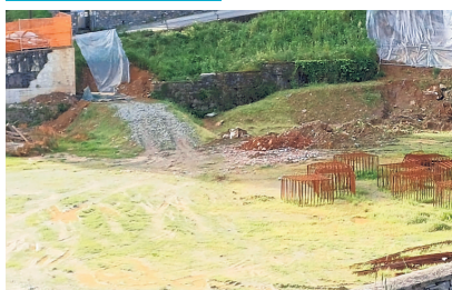
LAVORI AL PALO A FEZZANO
