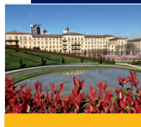
Milano Via Don Palazzolo 21
