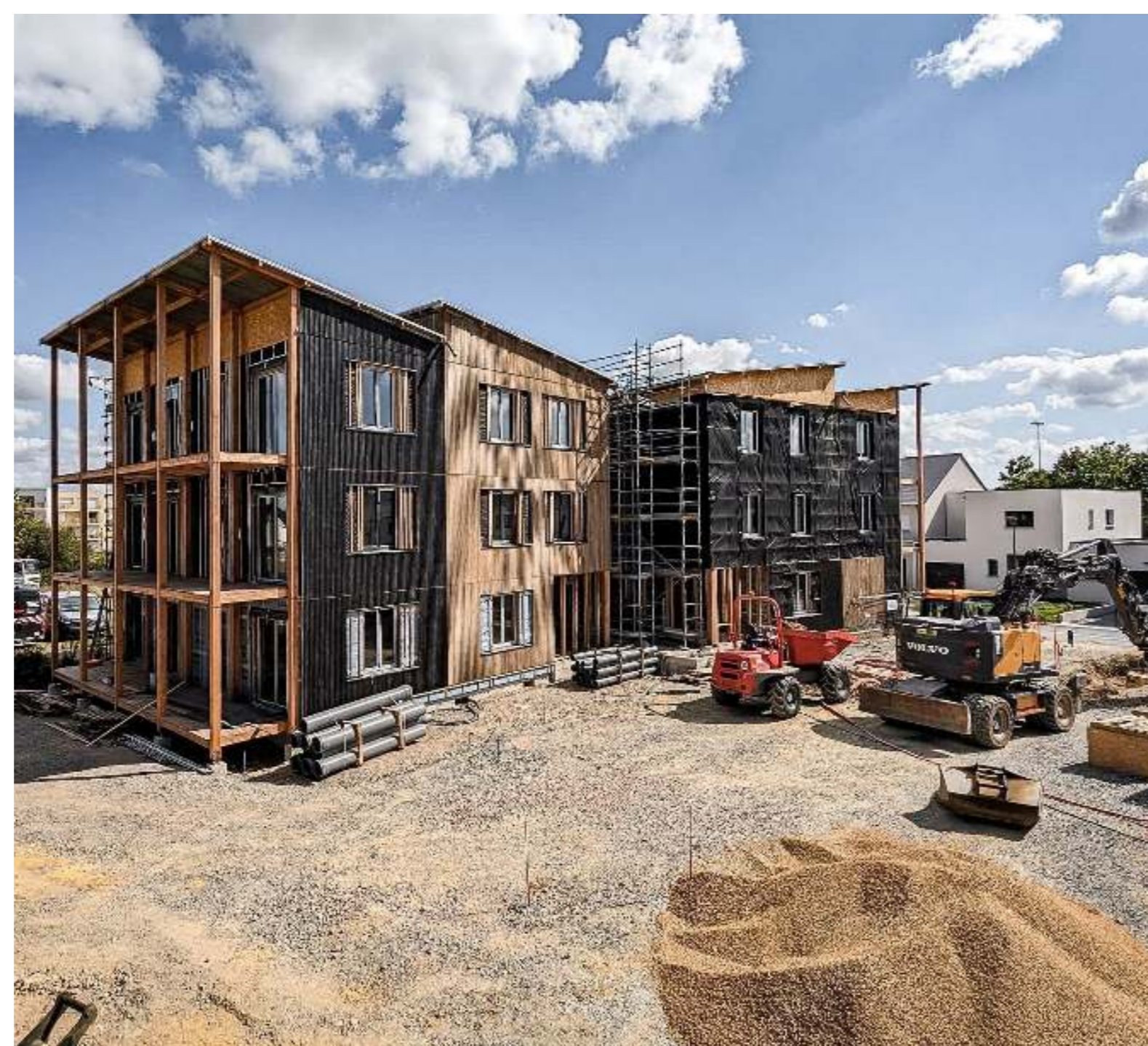
Les modules fabriqués par Vestack peuvent faire jusqu'à 13 m de long et 4 m de large afin de pouvoir être transportés par convoi exceptionnel.
