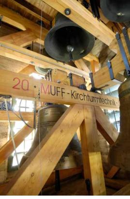
Dalla metà del XIX secolo vengono realizzati anche ceppi in acciaio. Una struttura in legno massiccio dura sei volte più a lungo rispetto a una in acciaio. Perché il legno si deforma, ma non si corrode e le saldature non cedono. Inoltre, il legno è in grado di sopportare le fluttuazioni di temperatura. Un altro vantaggio risiede nell'acustica. In combinazione con un mozzo in legno, il ceppo di legno consente di produrre un suono puro e molto piacevole.
