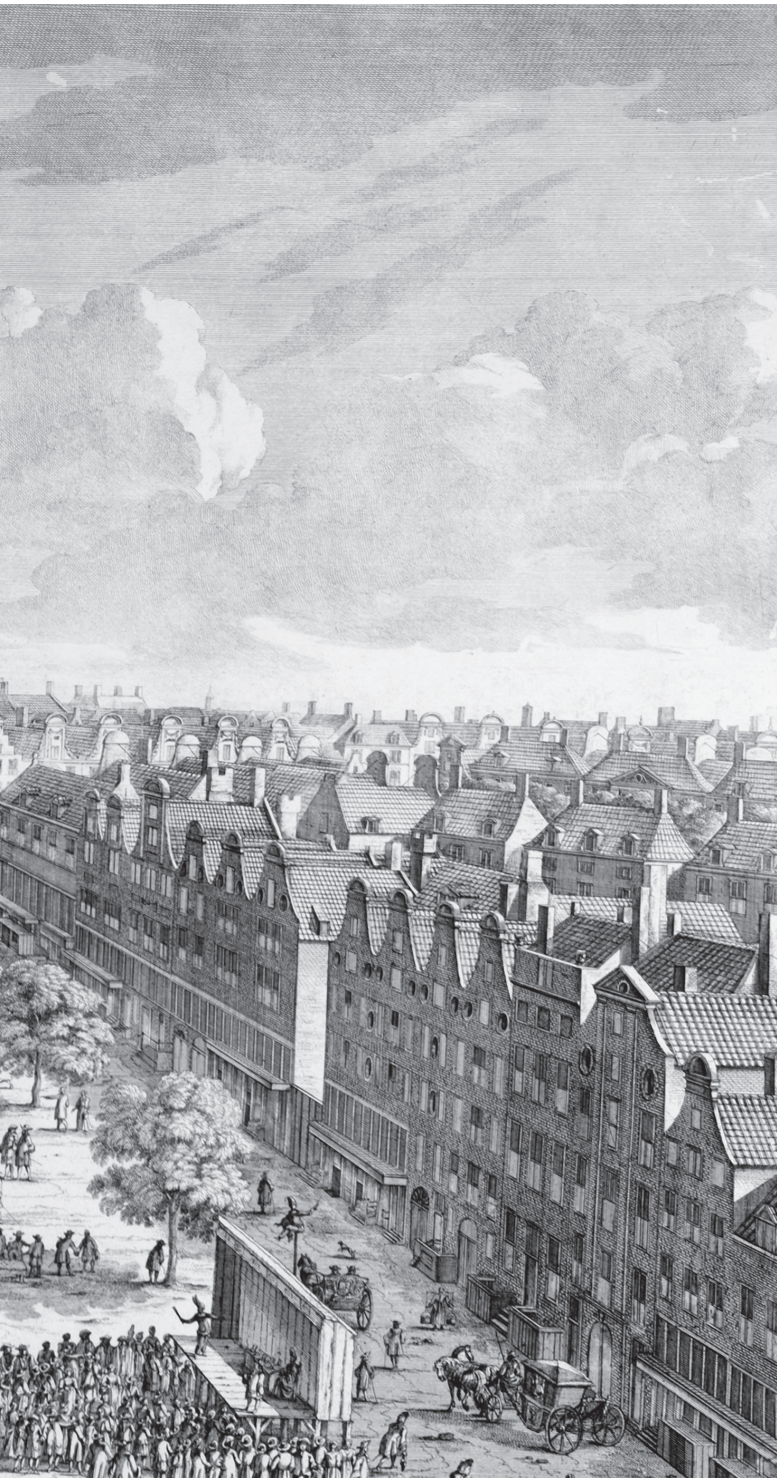
1. Gezicht op de Botermarkt naar het oosten met de Boterwaag en de door Listingh ontworpen koepelkerk. Gravure van Daniel Stoopendaal, uit: Niew Desseyn tot een Seer Grootte, Stercke, en om te hooren, heel bequame Coupel-Kerck met een hooge Tooren , ca. 1689/1695.
