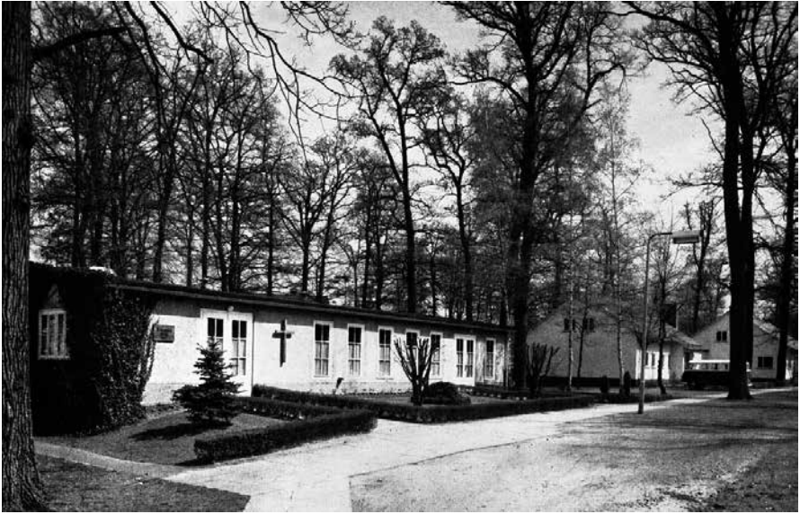
Het voormalige gebouw van de mennonieten-Gemeente bij Espelkamp (Bielefeld): vroege jaren zestig aan de Stolper weg: kerk (die voormalige Munahalle MH 56), een los huis en het Mennonitenheim (gebouwd in 1958/59).
