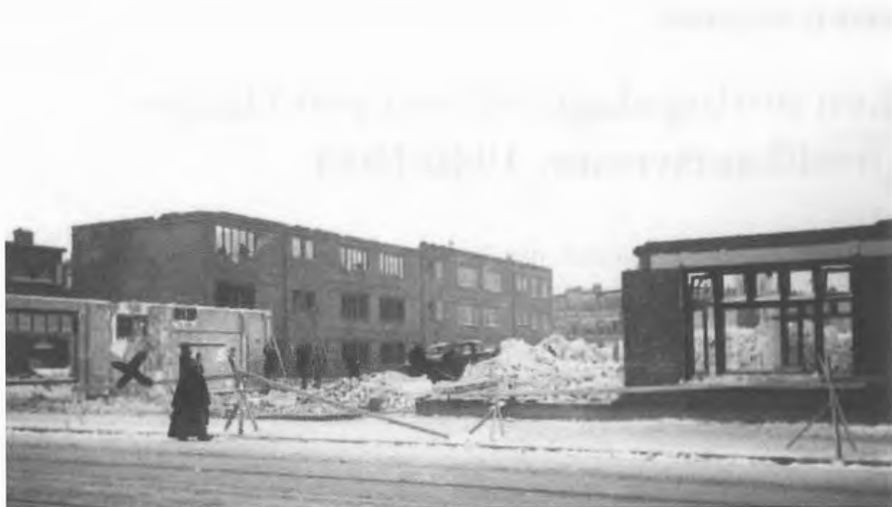
Dagboek 825 (2-3-1943). Foto, door zoon Menno Huizinga gemaakt, van de Irisstraat die door de bezetter wordt afgebroken i.v.m. de Atlantikwall . 'Ons huis staat er nog. Ze zijn met het dak begonnen; [...] Deze – en vele anderen – heeft Menno stiekum genomen, in een kistje op zijn fiets, want alles wat de weermacht doet, mag je niet fotografeeren'.
