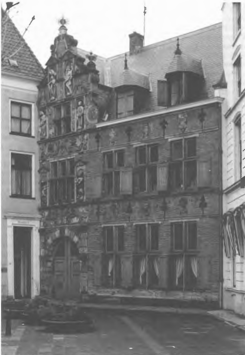
Afb. 2. Gerestaureerde gevel van de 'Penninckshoek' uit 1892.
