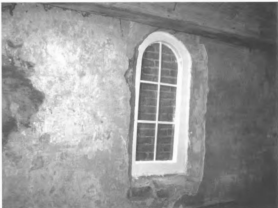
Het interieur van de voormalige vermaning te Balk met raam (foto: Roel Holkema).
