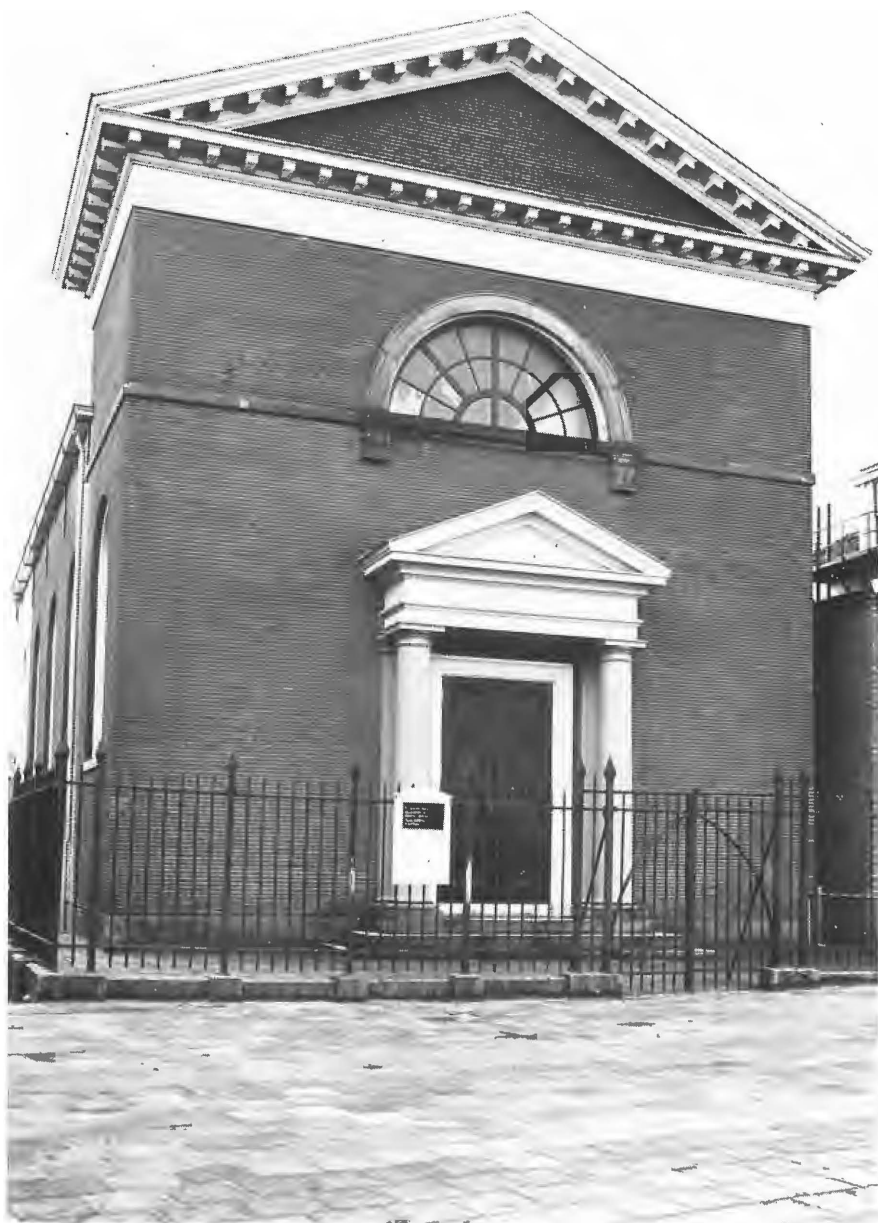
Fries-Doopsgezinde vermaning te Wormerveer. Architect H. Springer, gebouwd door zijn vader W. Springer voor f 21.500. De vermaning werd 9 oktober 1831 ingewijd. Exterieur.
