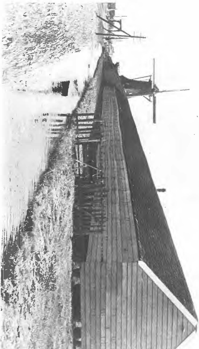
Papiermolen 'De Schoolmeester' (1692) te Westzaan van de Gebroeders De Jong. Papiermolens zijn te herkennen aan de grote schuven waar het papier te drogen wordt gehangen.
