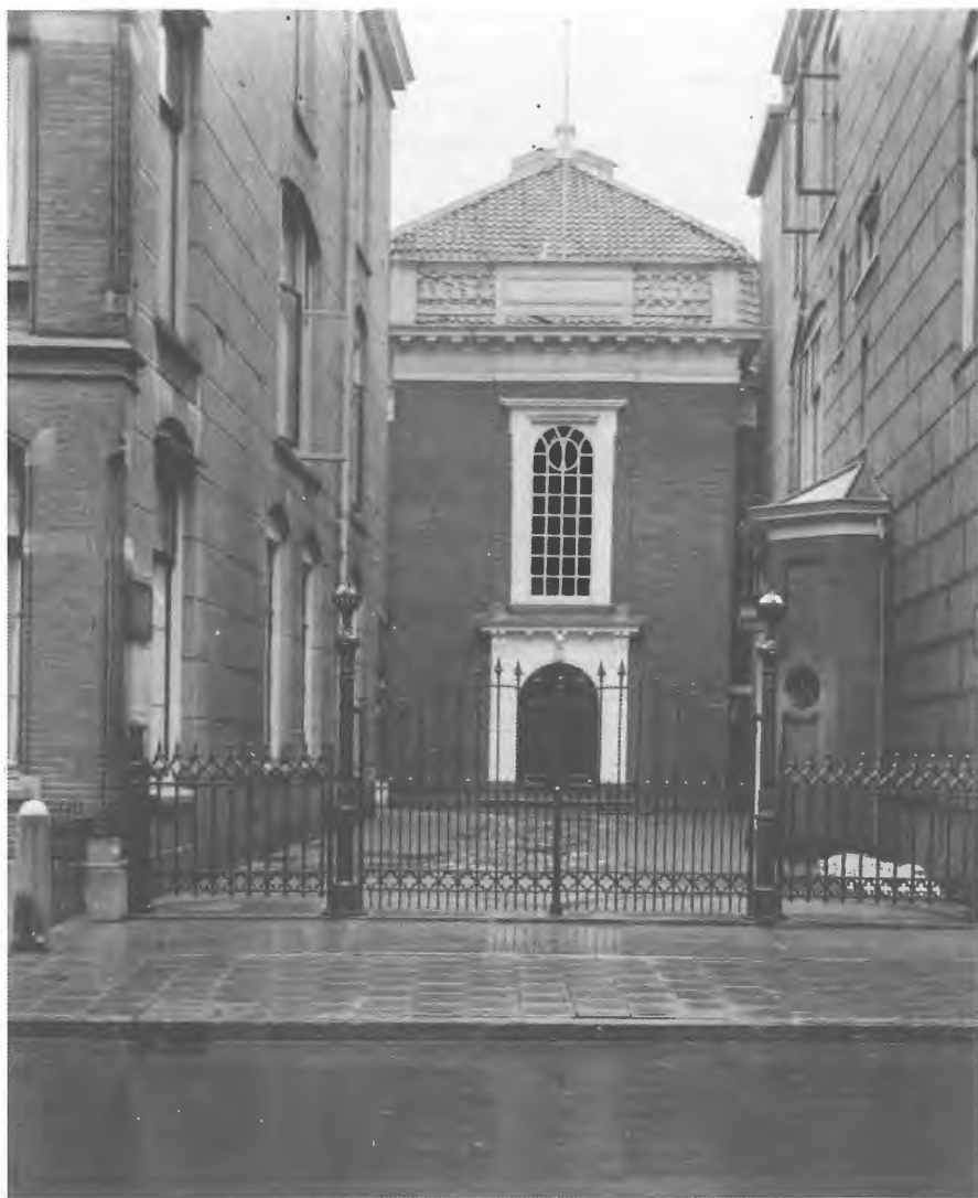
Ingangspartij van de uit 1815 daterende doopsgezinde kerk aan de Oude Boteringestraat te Groningen. Het gebouw verving een vermaning die aan het oog onttrokken werd door de kosterswoning. Bij de nieuwbouw werd deze woning afgebroken, zodat het plein ontstond. Een teken van de nieuwe tijd die in de negentiende eeuw aanbrak. (Collectie Gemeentearchief Groningen; foto: P.B. Kramer.)
