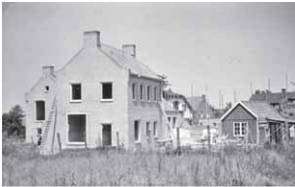
Complex in aanbouw gezien vanaf de belendende Beatrix-school (nu: Vrije school) (beide foto's: Gemeentearchief Wageningen).
