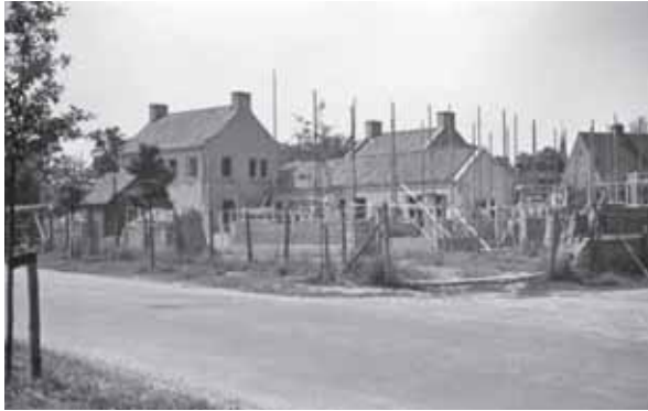
Complex in aanbouw gezien vanaf hoek Aug. Faliseweg/Arboretumlaan.
