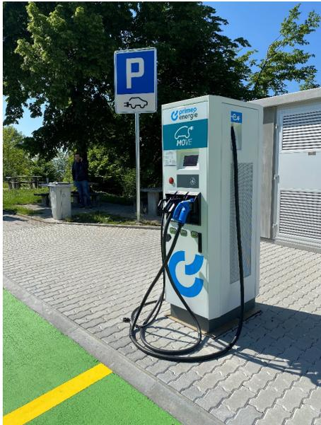
Ladekabel am Boden vor der Säule erschweren den Zugang für Rollstuhlfahrer.
