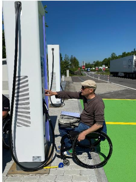
Bedienelemente der Ladesäule (Kabel und Display) maximal 0,25m vom Manövrierebereich entfernt, max. 1.1m über Boden (Achtung Sockel!)
