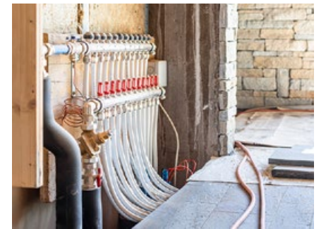
Noch im Bau: Im Hauptgebäude sind die Verteiler der Fussbodenheizung noch bestens sichtbar.
