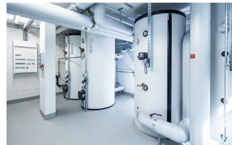
Die neue Anlage mit der Wärmepumpe (links oben) und den vier Speichern (links unten).
