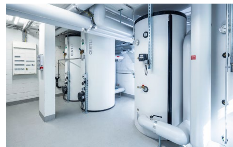
La nouvelle installation avec la pompe à chaleur (en haut à gauche) et les quatre accumulateurs (ci-contre).
