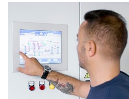
Grâce au système de gestion technique du bâtiment de Sauter, Luca Negro peut consulter à tout moment les paramètres des installations.
