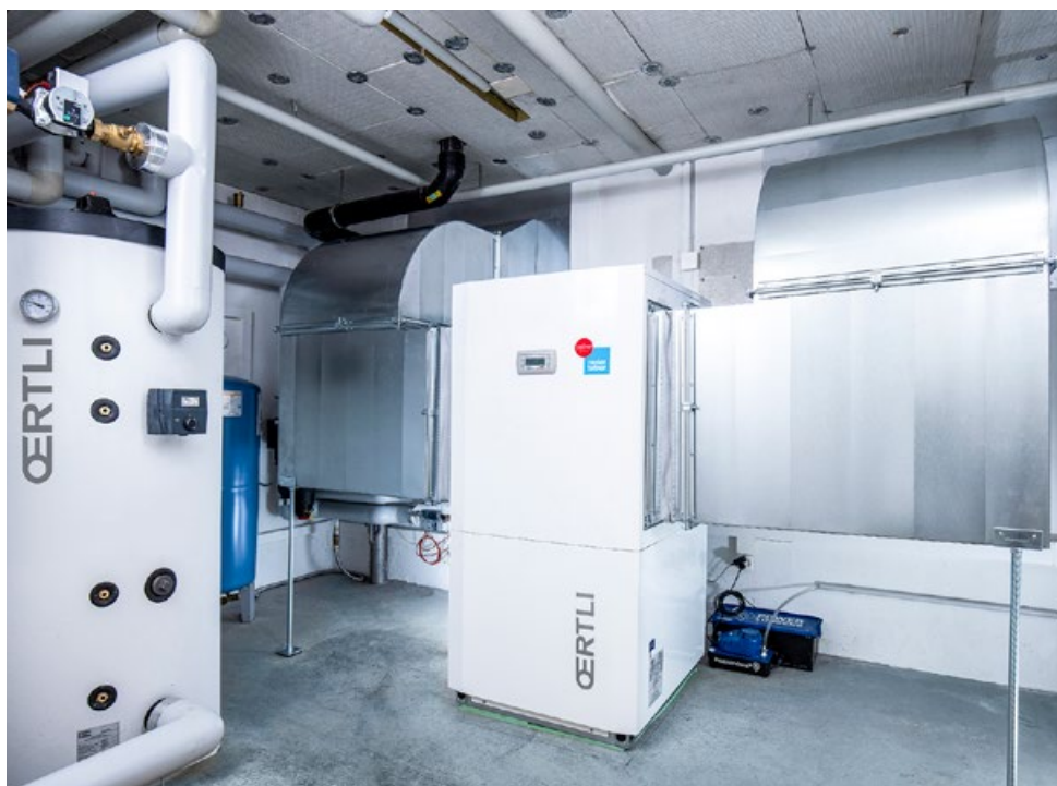
Die neue Luft-Wasser-Wärmepumpe als Herzstück der neuen Anlage (links). Zufrieden mit der Umsetzung (v. l.): Andreas Schafflützel, Heinz Frühwirt und Patrick Schlichting (ganz oben). Und elegant gelöster Ansaug und Ausblas (oben).
