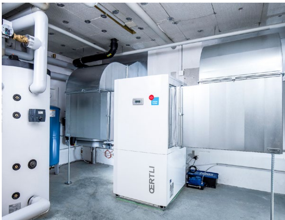
La nouvelle pompe à chaleur air-eau, élément central de la nouvelle installation (ci-contre). Satisfaits de la mise en œuvre (d. g. à d.) : Andreas Schafflützel, Heinz Frühwirt et Patrick Schlichting (en haut). Ci-dessus : la réalisation élégante de l'aspiration et de l'évacuation.
