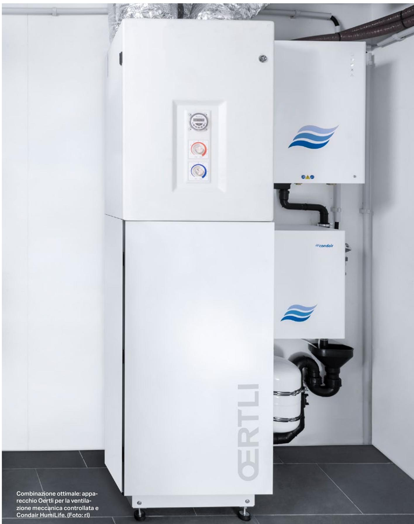
Combinazione ottimale: apparecchio Oertli per la ventilazione meccanica controllata e Condair HumiLife. (Foto: rl)
