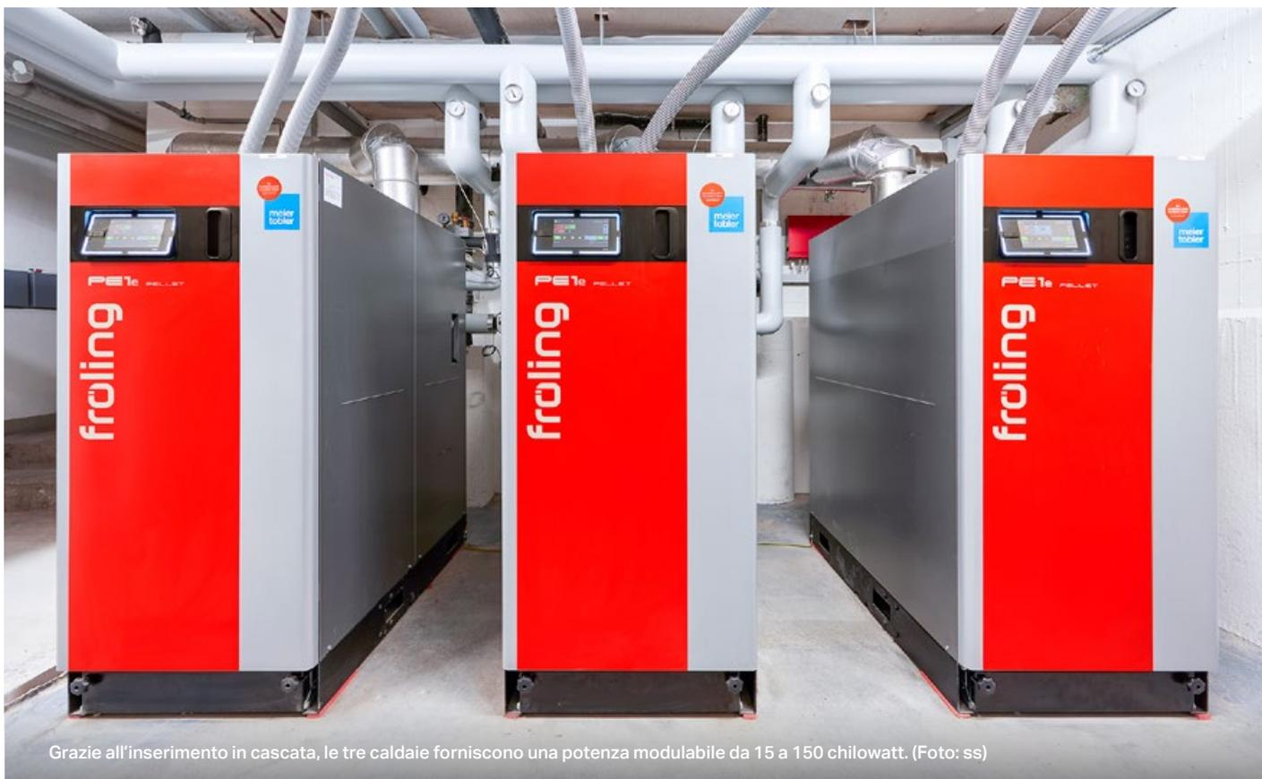
Grazie all'inserimento in cascata, le tre caldaie forniscono una potenza modulabile da 15 a 150 chilowatt. (Foto: ss)
