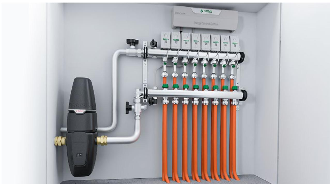
Sempre più proprietari di casa optano per un sistema a bassa temperatura, come un riscaldamento a pavimento. Il funzionamento di questi sistemi può tuttavia essere pregiudicato dalla presenza di ossigeno e altri gas. Distribuzione disomogenea del calore, corrosione, formazione di biofilm e ostruzioni sono le possibili conseguenze. L'inefficienza comporta maggiori spese di esercizio. E nel peggiore dei casi si potrebbe persino verificare un guasto totale dell'impianto.
