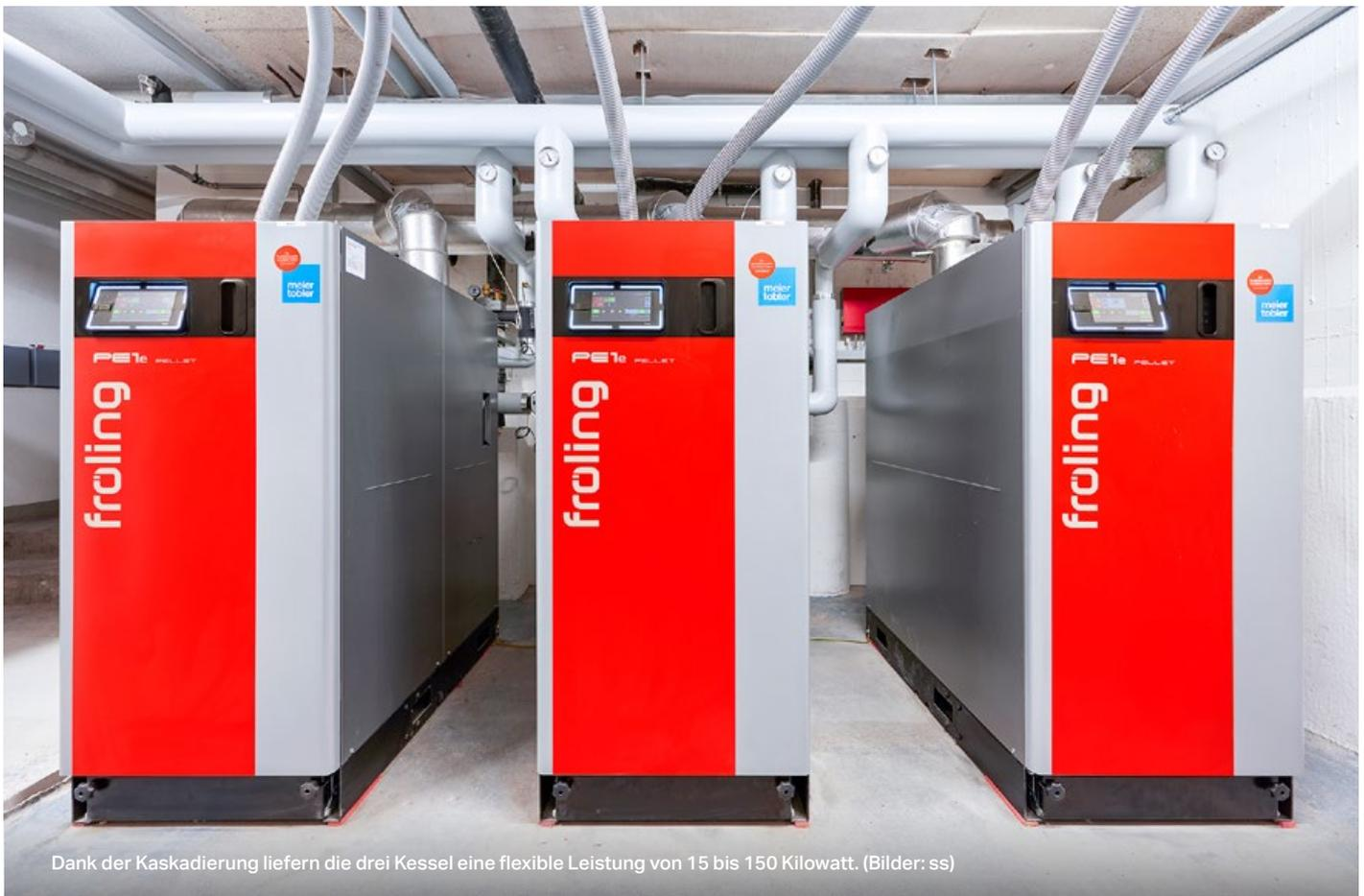
Dank der Kaskadierung liefern die drei Kessel eine flexible Leistung von 15 bis 150 Kilowatt. (Bilder: ss)
