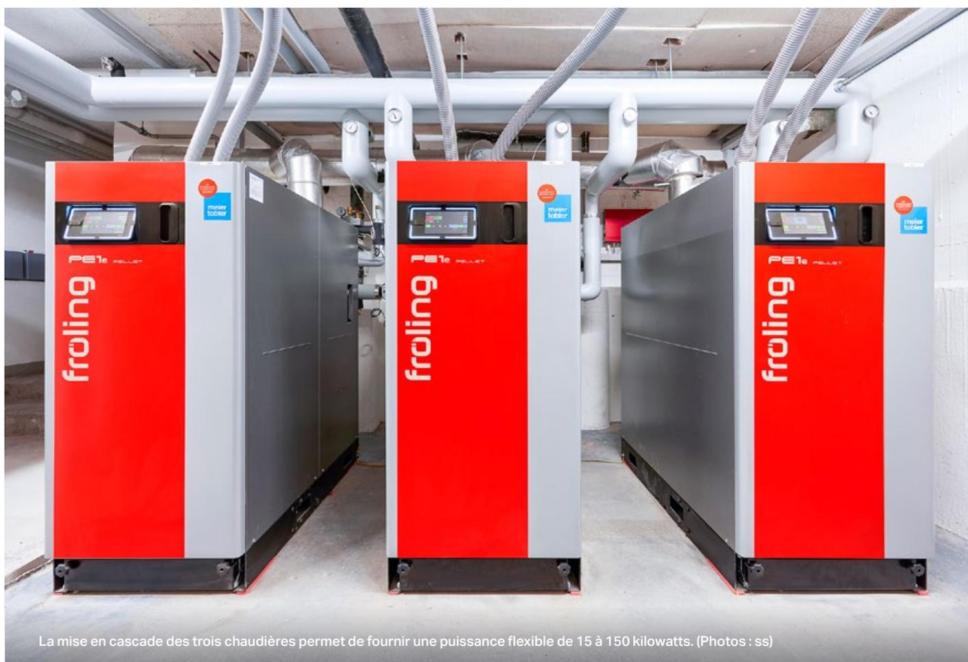
La mise en cascade des trois chaudières permet de fournir une puissance flexible de 15 à 150 kilowatts. (Photos : ss)
